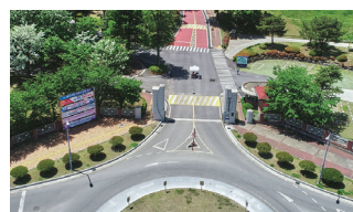
15 정문 Main Gate
